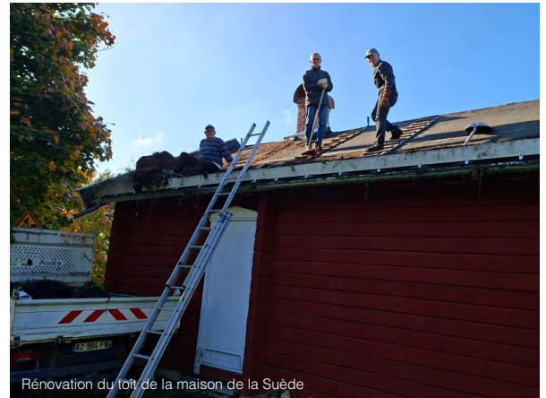
Rénovation du toit de la maison de la Suède
