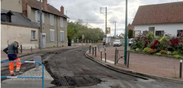
Dernièrement, des travaux ont été réalisés dans la rue de la Forêt et sur un tronçon de la rue de la Brégaudière jusqu'au rond-point du Château : sous le sol, les branchements des eaux usées défectueux ont été repris, le réseau d'assainissement a été étanchéifié grâce à un chemisage des canalisations. Au niveau de la voirie, une réfection du tapis a été réalisée.
